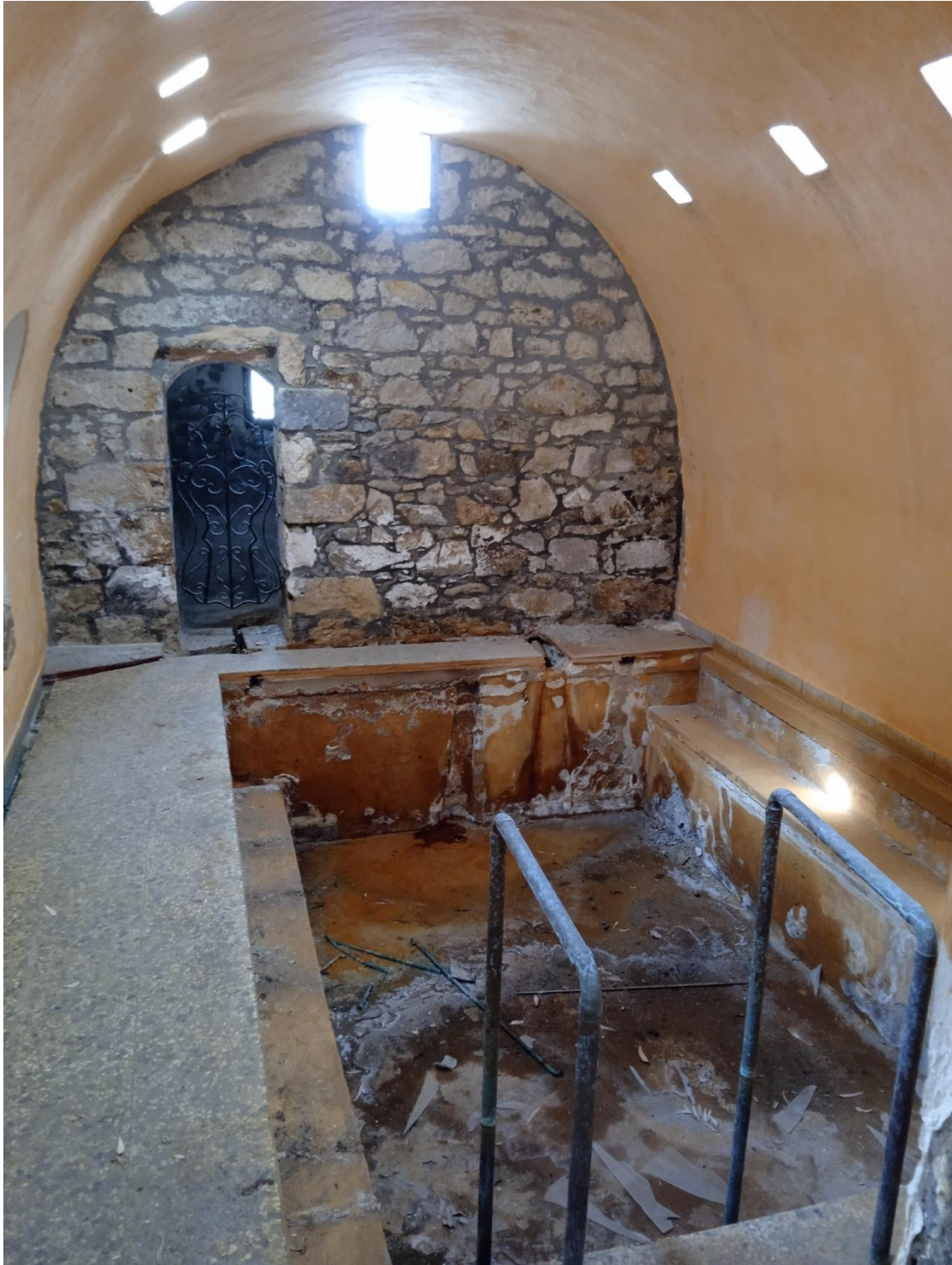
Ακίνητο Β, εσωτερικό λουτρών (δεξαμενή α)
