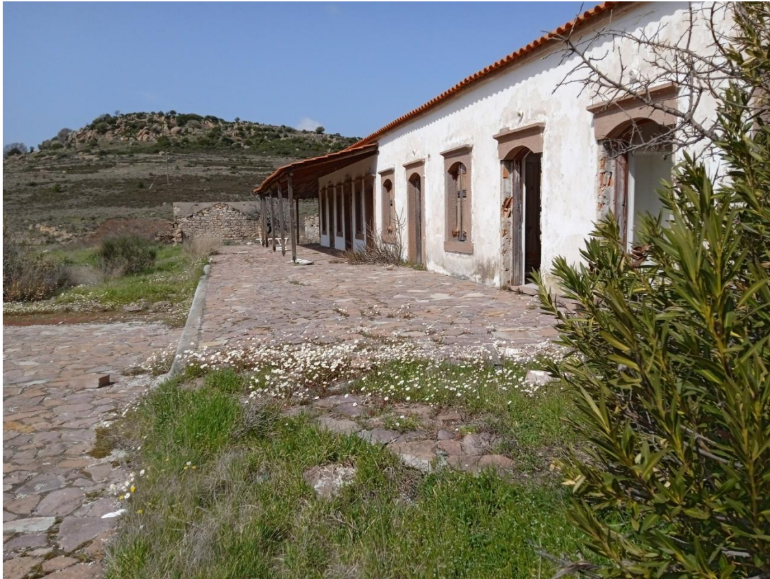
Ακίνητο Α, Ξενώνας, Ν όψη
