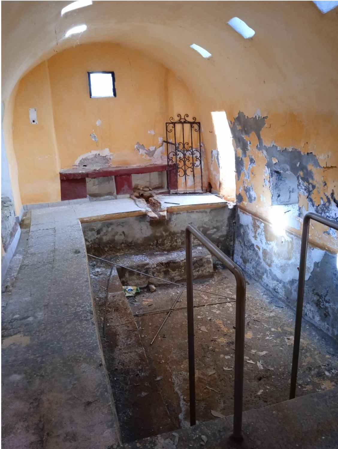
Ακίνητο Β, εσωτερικό λουτρών (δεξαμενή β)
