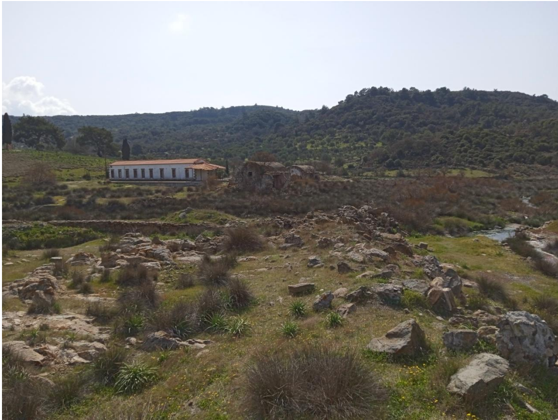
Ακίνητο Α, ΒΔ όψη εγκαταστάσεων
