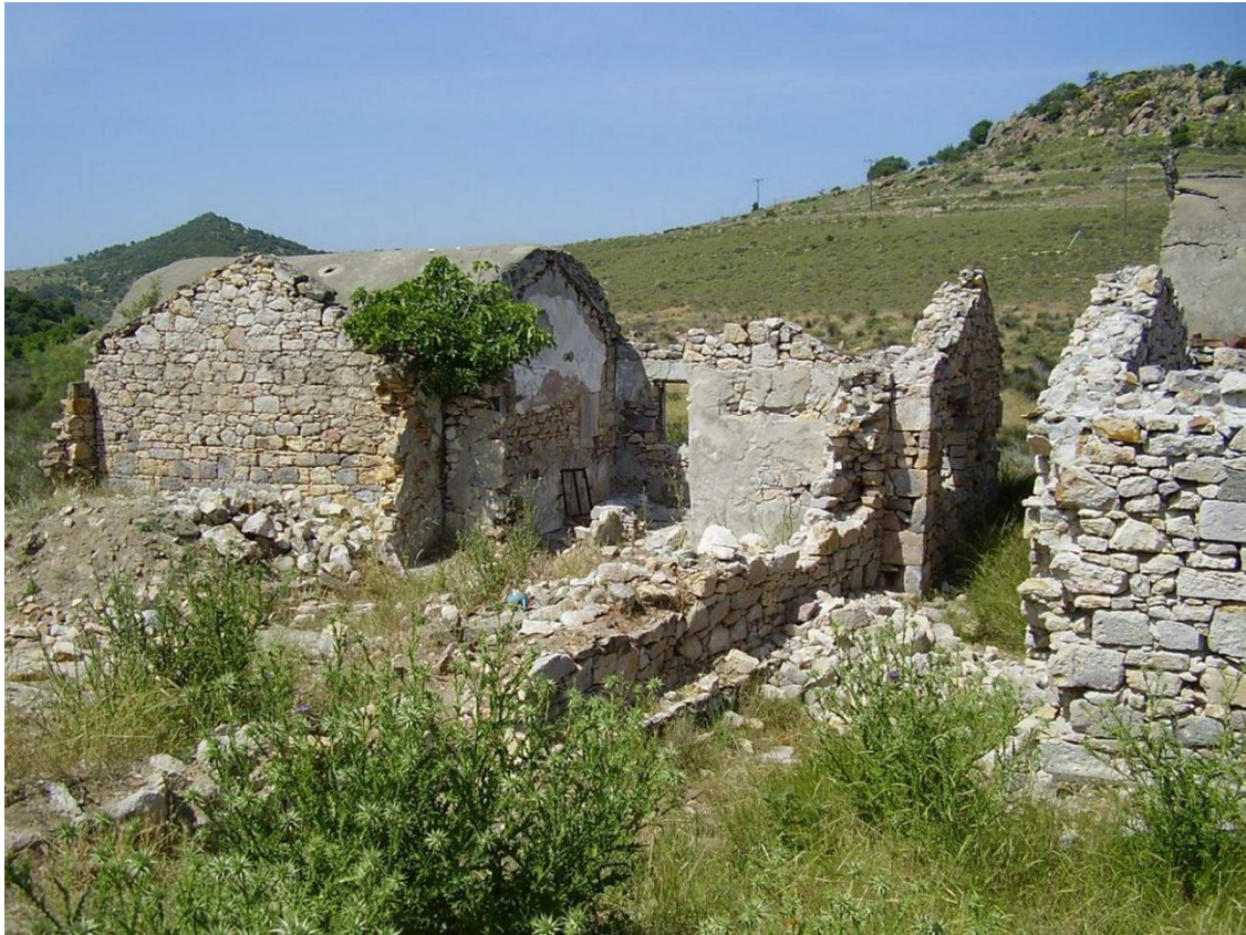
Ακίνητο Α, ερείπια κτισμάτων
