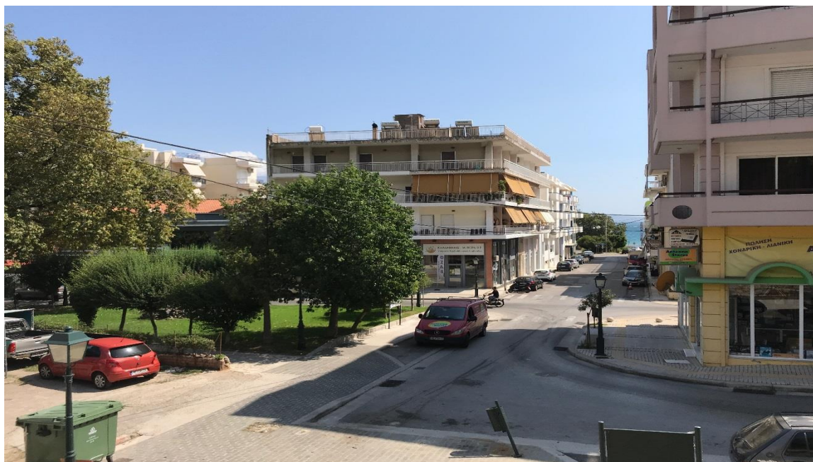
Φωτογραφία 21: Άποψη της οδού Κορυδαλλέως (Διάγραμμα Ε, Θέση 21)
