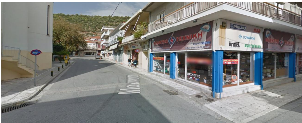
Φωτογραφία 19: Άποψη της οδού Μακκάση (Διάγραμμα Γ, Θέση 19)
